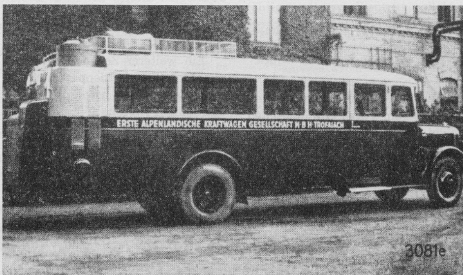
Bild 5. Umgebauter Autobus mit Saurer-Motor BN (Imbert-Gaserzeuger)
